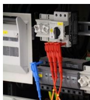
Abb. 4: Beispielschluss Spannungspfad
